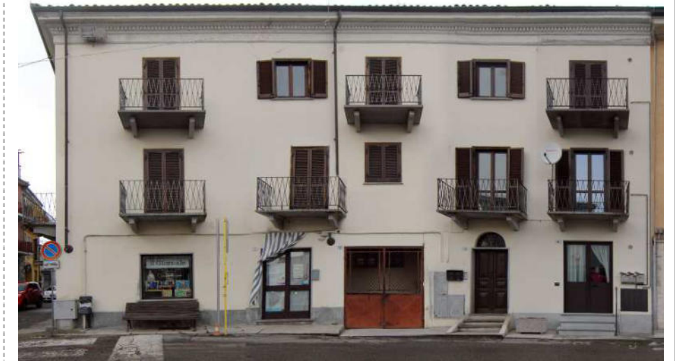
L'analisi dello stato attuale del fabbricato ha portato ad evidenziare una perdita parziale dello stato originale, rimanendo comunque ; Si notano principalmente la perdita rilevante degli elementi decorativi e delle originali scansioni di facciata. E' evidente la perdita di centralità nel tessuto acuita dall'impovertimento del fronte piazza.
