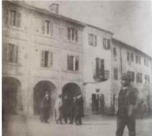
Municipio (edificato tra la fine del XVIII ed inizio del XIX sec. ) con portici e fabbricati limitrofi ( foto fine XIX secolo)
