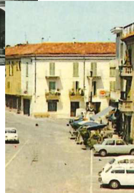
Si nota inoltre come attorno a metà secolo siano stati demoliti e ripensati il ballatoio al secondo piano e sia stato modificato il portone d'accesso. (foto 1970)
