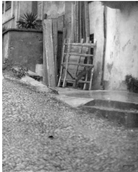
Particolari della pavimentazione originale in ciottoli
