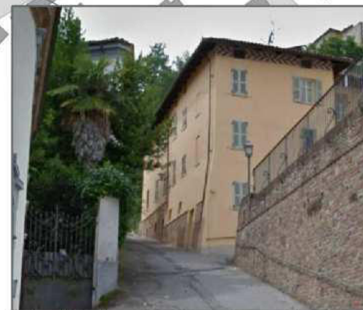
Salita al Catello Interventi di recupero del patrimonio edilizio tutelato, attenzione a modalità di intervento e materiali
