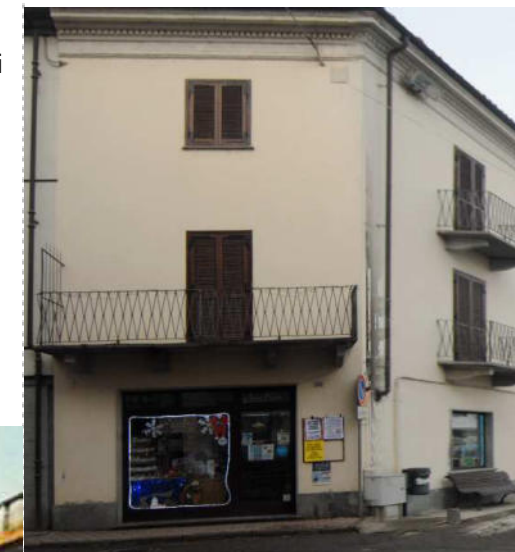
Le finiture esterne sono intonacate, sono presenti fasce marcapiano e un abbaino a formalizzare l'edificio e impreziosirlo rispetto ai canoni dell'architettura tradizionale
