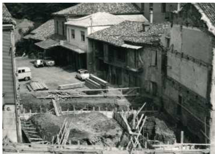
Nel 1969 si assiste alla demolizione dell'edificio su cui sarà poi ricostruita la sede bancaria, la sede della banca agraria rimane traccia per l'intervento.
